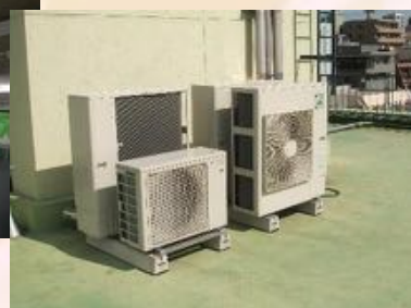
空調設備の改修工事
